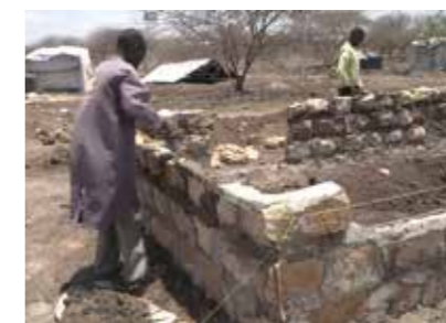
建設風景。UNHCRは住居の建て方と必要な建材についてのリーフレットを事前配布
